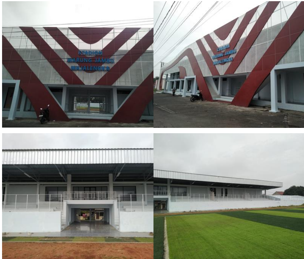
Gambar Rehabilitasi Stadion Warung Jambu
