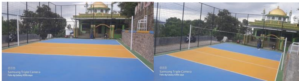
Gambar Rehabilitasi Prasarana Olahraga Desa
